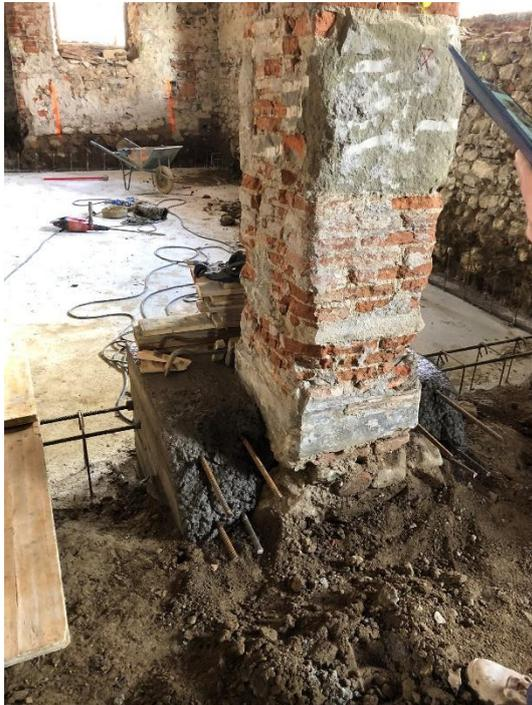
Vista di sottofondazione di struttura portante
