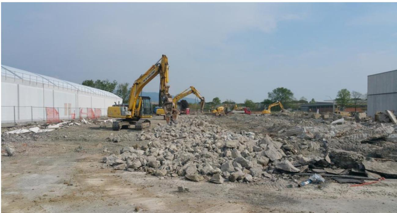
*Demolizione del capannone danneggiato dall'incendio*
