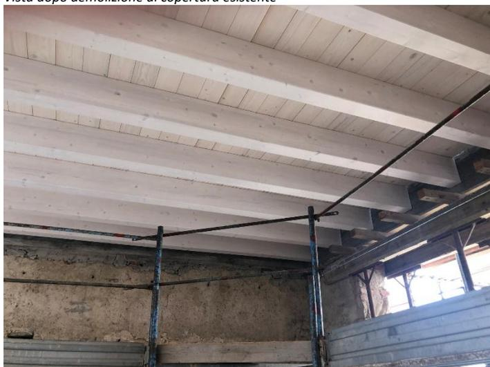
*Vista interna dopo realizzazione di solaio in legno*
