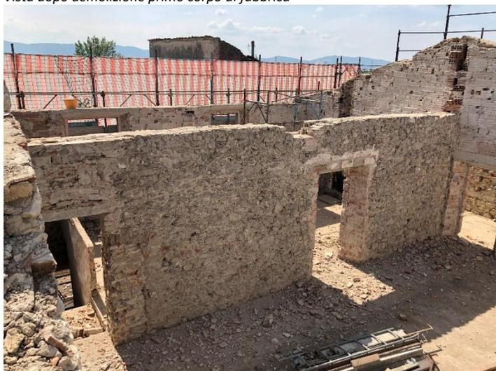
*Vista dopo demolizione di copertura esistente*
